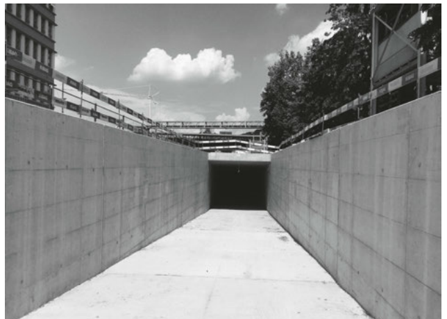
Noch im Rohbau: Zufahrtsrampe in der Kasernenstrasse. (Bild: TAZ)
