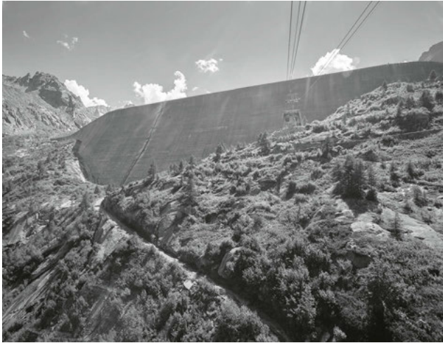
Werkseilbahn vor Staumauer Albigna mit Kunstobjekt «Riss». (Bild: ewz)
