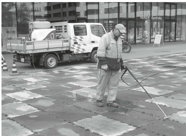
Heisswassereinsatz gegen Ritzenvegetation. (Bild: TAZ)
