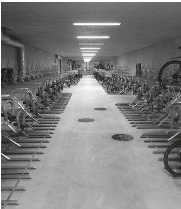
Velostation mit 390 Abstellplätzen in der Quartierverbindung Oerlikon. (Bild: TAZ)
