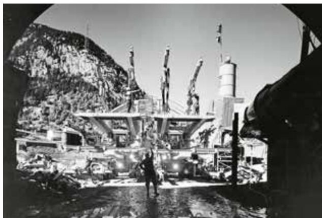
Gotthard-Strassentunnel Nord, selbstfahrende Bohrmaschine vor dem Einsatz im Tunnelbau, 1970. Aufnahme des Zürcher Fotografen Michael Wolgensinger (Signatur: Stadtarchiv Zürich, VII. 271. Michael Wolgensinger [1913–1990]).
