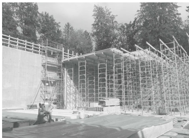
Baufortschritt Reservoir Käferberg im August. (Bild: Wasserversorgung)
