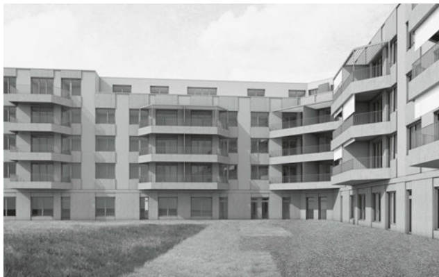
Die Wohnsiedlung Herdernstrasse ist energetisch und ökologisch vorbildlich: Sie wird im Minergie-P-ECO-Standard erstellt, die Wärmeversorgung erfolgt mit Fernwärme von der Heizzentrale Hardau. (Bild: Nimbus Architekten GmbH, Zürich)
