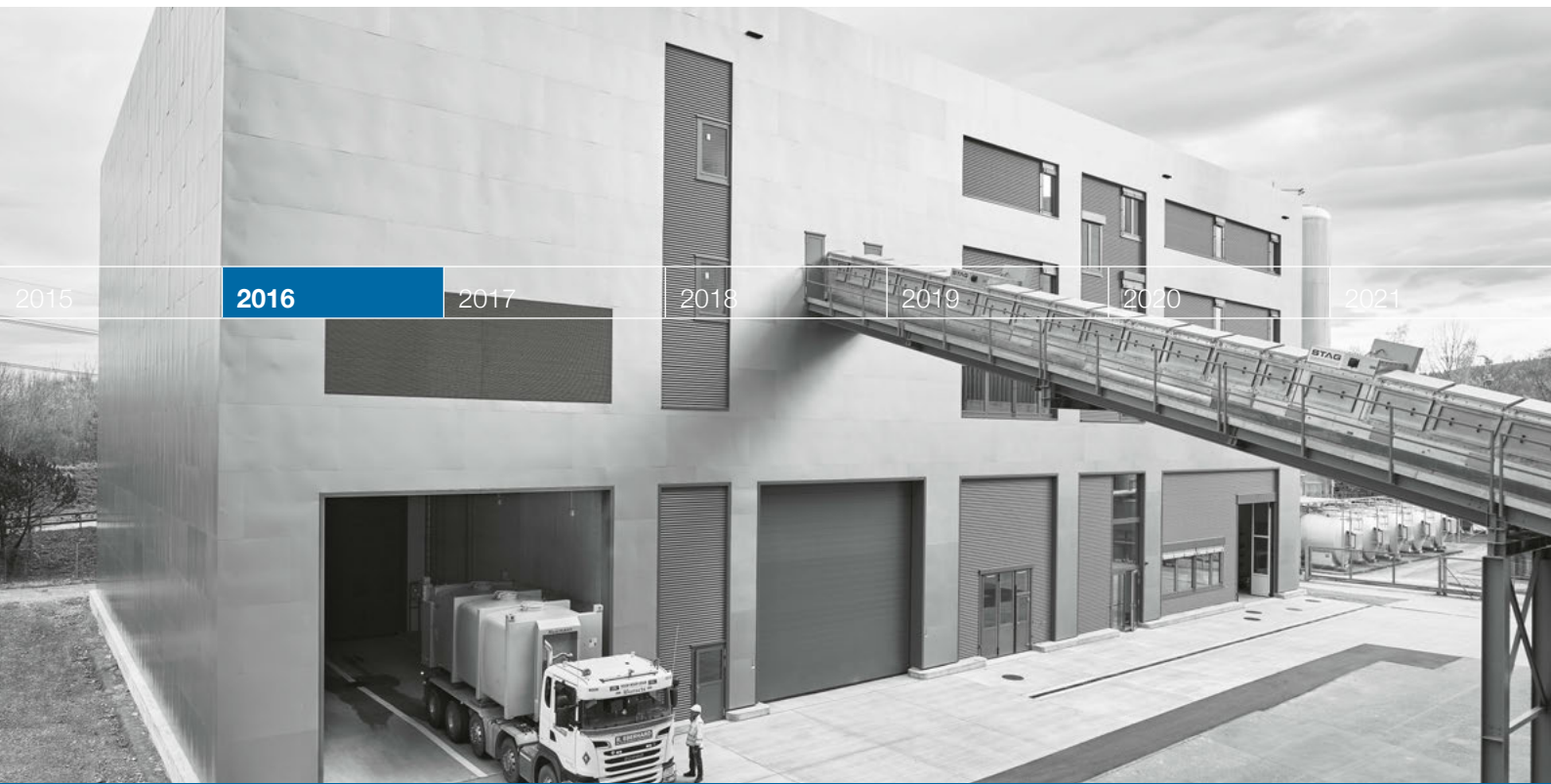
Neue Containerhalle Hagenholz (Bild: ERZ)
