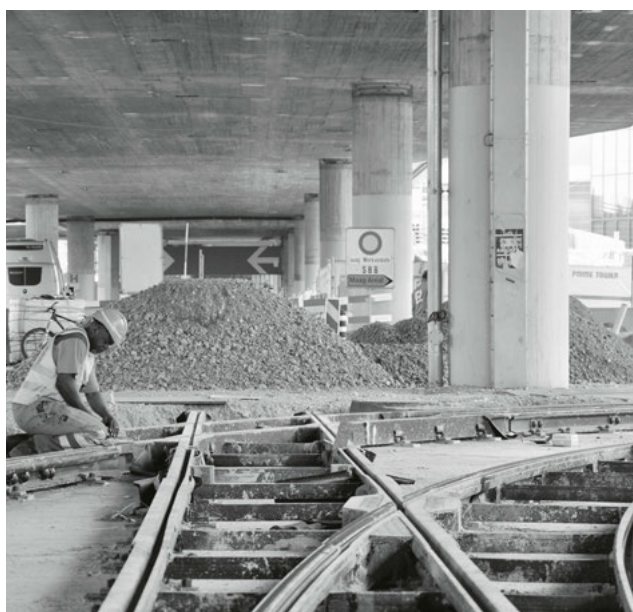
Bauarbeiten für die neue Tramverbindung Hardbrücke. (Bild: VBZ)
