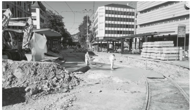
Die Werkleitungskulisse unter dem Löwenplatz erhält eine neue Abdichtung. (Bild: TAZ)
