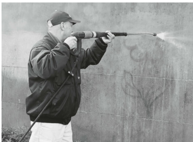
Graffiti-Entfernung auf einer mit Aravel® vorbehandelten Natursteinmauer. (Bild: Priska Rast)
