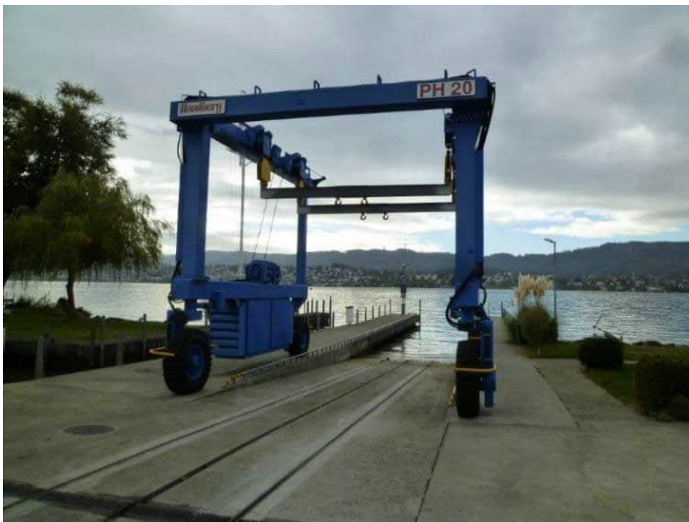
Abbildung 18: Travellift-Anlage am heutigen Standort bei der WAPO (Foto Ecosens)
