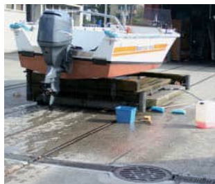
Waschplatz mit Anschluss an die Kläranlage
