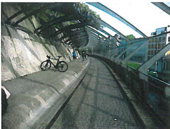
Leerstehende Fläche über den Geleisen (Zugang von Schanzengasse)
