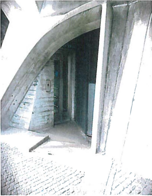
Aufzugsanlage zu den Perrons
