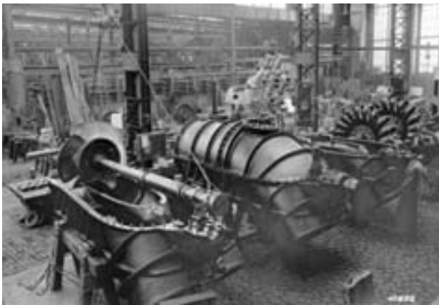
Aus dem Bildarchiv der Firma Escher Wyss: drei Pumpen für Wasserturbinenwerke in der Fabrikationshalle der Escher Wyss. (Bild: Stadtarchiv)
