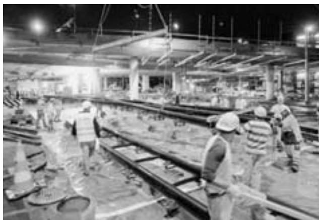
Gleisbauarbeiten rund um die Uhr im Sommer 2010 am Escher-Wyss-Platz. (Bild: TAZ)
