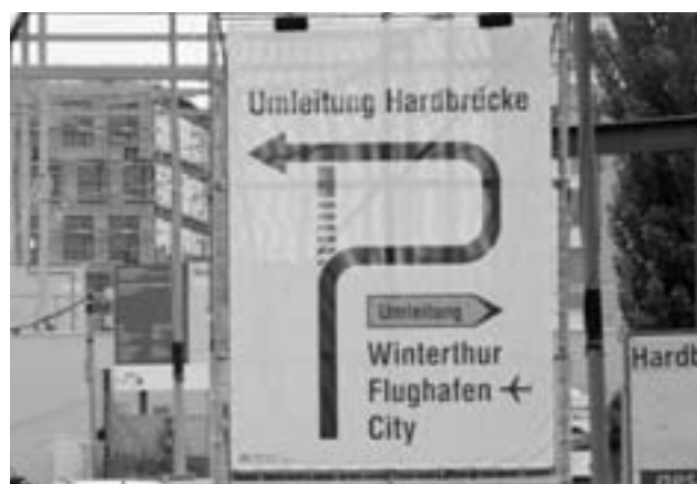
Mega-Plakate als neue Baustelleninformation: Hardbrückensanierung 2010. (Bild: Heiko Ciceri)
