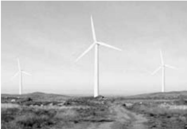
Windpark Hög Jaeren.
