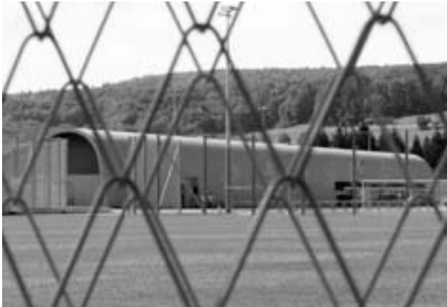
Die komplett erneuerte Sportanlage Heerenschürli ist auch ein Naherholungsraum für das Quartier Schwamendingen. (Bild GSZ)
