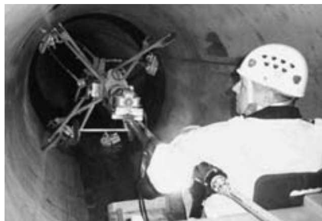
Maschineneinsatz für die Stollenreinigung.
