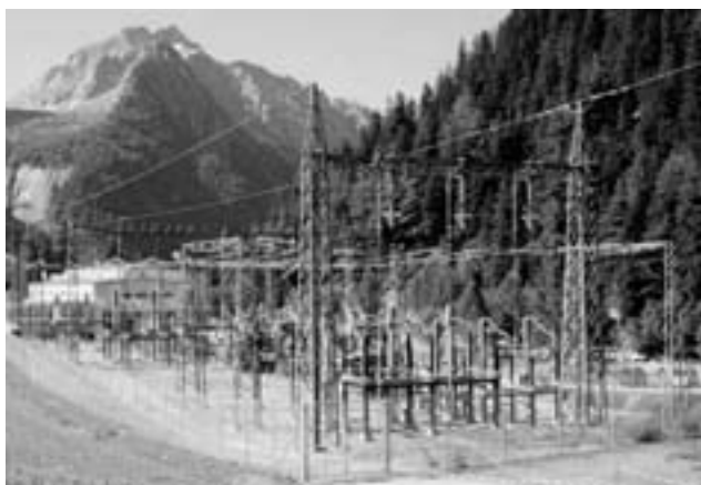
Erneuerte 220-kV-Schaltanlage.
