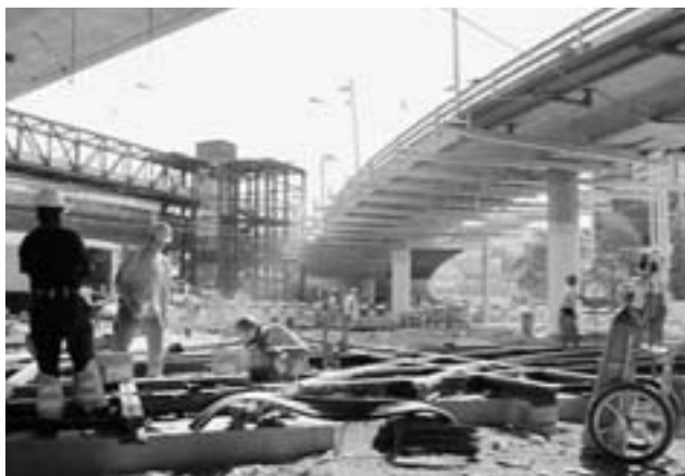
Grossbaustelle am Escher-Wyss-Platz.
