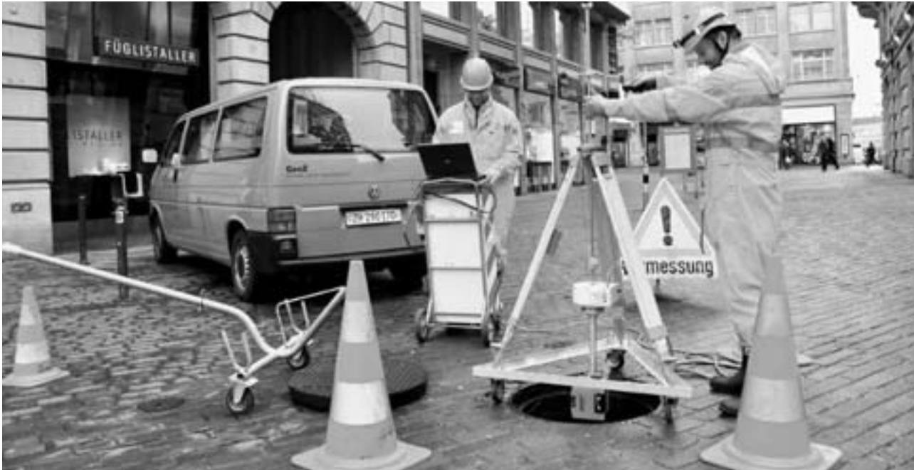
Kanalvermessung mit Laserscanning. (Bild GeoZ)
