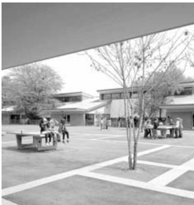
Ausgezeichnet: Furaldächer im Schulhaus Untermoos, instandgesetzt von Diethelm Spillmann Architekten. (Bild: Roger Frei)
