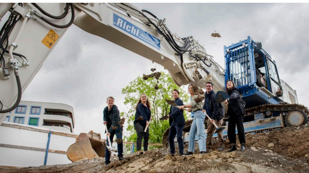
Spatenstich an der Flurstrasse 115. Foto Mirjam Graf
