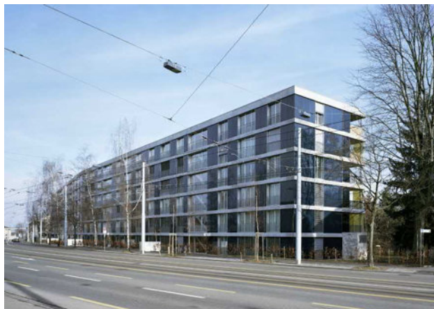
Bestandsbau Ansicht Hofwiesenstrasse
