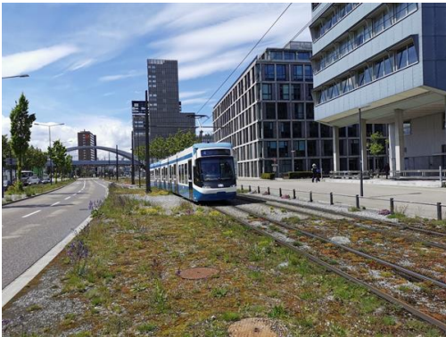
Abbildung 2: Schotterrasen bei der Haltestelle «Technopark». (Bild: VBZ)
