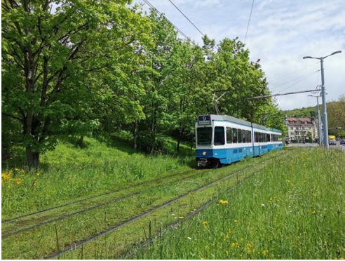
Abbildung 1: Intensiv begrüntes Rasengleis zwischen den Haltestellen «Universität Irchel» und «Milchbuck». (Bild: VBZ)
