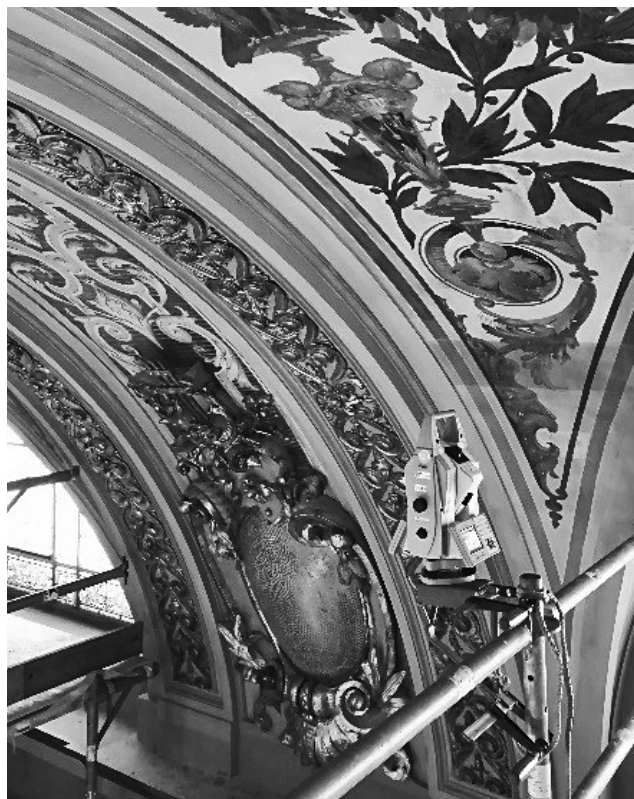
Baustelle Kongresshaus: Einsatz einer Totalstation. (Bild: GeoZ)
