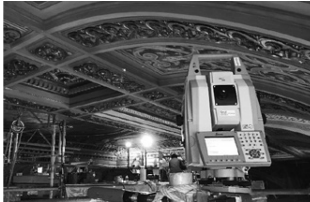
Baustelle Kongresshaus: Einsatz einer Totalstation. (Bild: GeoZ)
