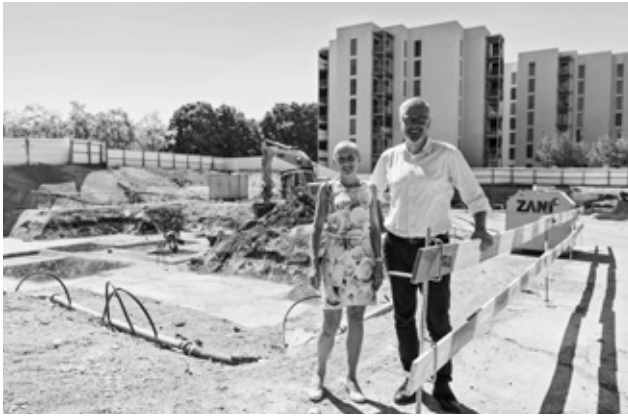
152 neue SAW-Wohnungen: Direktorin Andrea Martin-Fischer und Stadtrat Andreas Hauri besuchten am 27. Juni 2018 die Baustelle der Ersatzneubauten der SAW-Siedlung Helen Keller in Schwamendingen. (Bild: Ethan Oelman)
