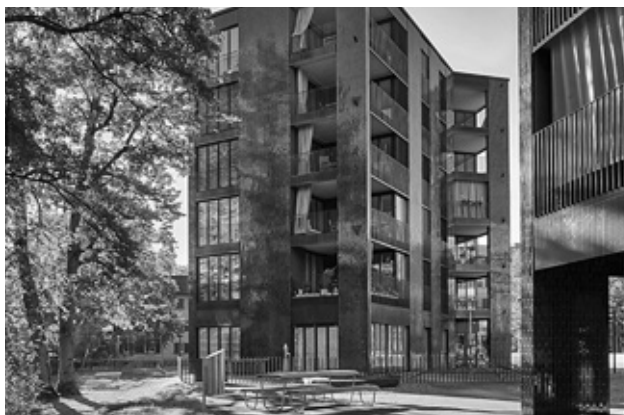
In der Siedlung Am Katzenbach V realisiert die Baugenossenschaft Glattal Zürich (BGZ) die letzte von fünf Ersatzneubau-Etappen. Es entstehen vier Gebäude mit einem vielfältigen Wohnungsmix. 27 Wohnungen werden subventioniert. Architektur von BS+EMI Architektenpartner AG. (Visualisierung: BGZ)
