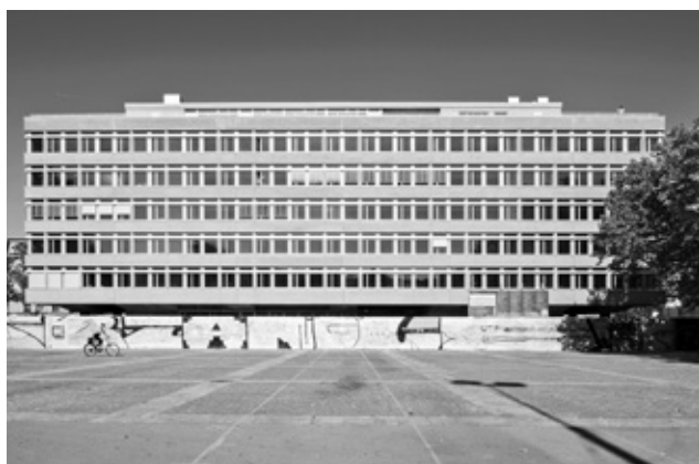
Amtshaus Helvetiaplatz im Umbau. (Bild: Juliet Haller)
