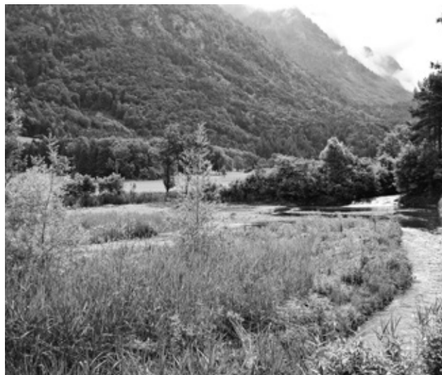
Aus dem kanalisiertem Berschnerbach wurde ein geschwungenes Niederwassergerinne: Ein verbreiteter Bachraum mit verschiedenen Kiesbänken bietet verschiedene Strömungsgeschwindigkeiten und neue Lebensräume. (Bild: ewz)
