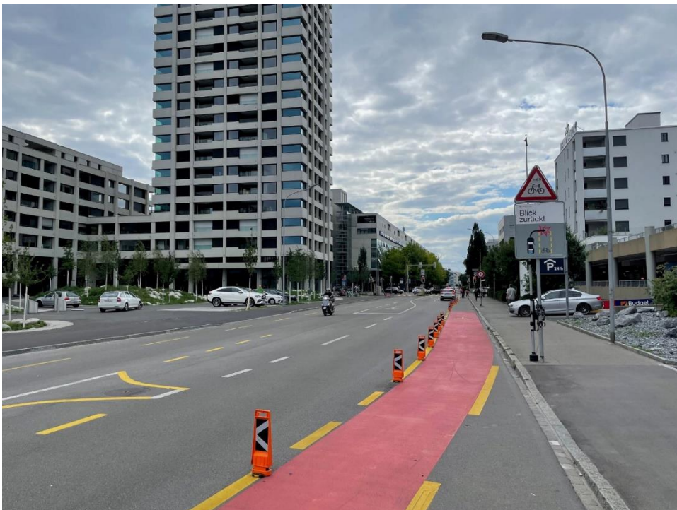
Foto: mit Leitbaken geschützter Velostreifen (Stufe 4), Baslerstrasse
