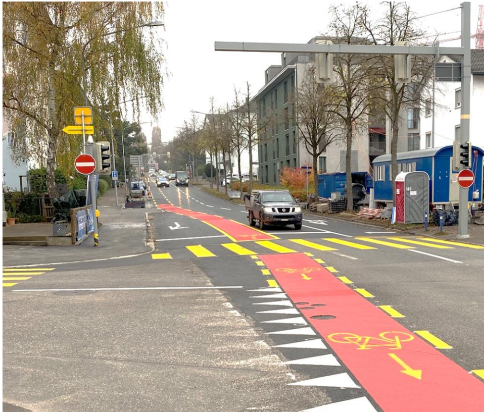
Foto: Unfallherd Dörfli-/Schwamendingenstrasse nach dem Umbau
