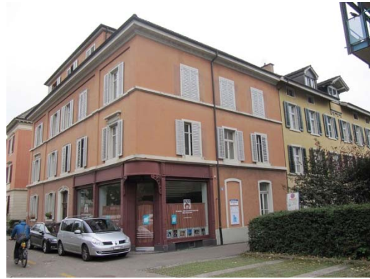
Bild 9: Gebäude Freiestrasse 56 und 58. Im Vordergrund Eingang des Theaters Metzenthin Quelle: Planpartner
