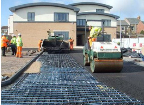
Bild: Einbau von Asphaltkollektoren (Quelle: Schlussbericht «Methoden der Erdsonden-Regeneration», Amt für Hochbauten, 2017)
