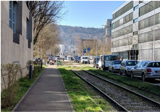
Abbildung 3-8 Anschlussgleich Ist-Zustand, Abschnitt bei Flurstrasse 65 (Bild: Machbarkeitsstudie [8])
