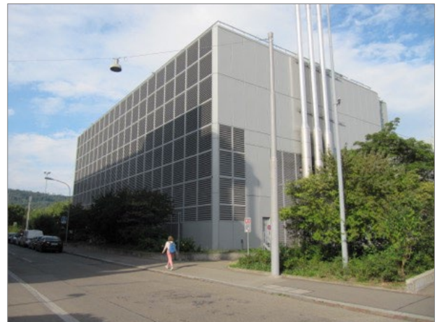
Abbildung 2-6 EWZ-Energiezentrale Flüelastrasse 28 (Foto Planpartner, 08.08.2017)
