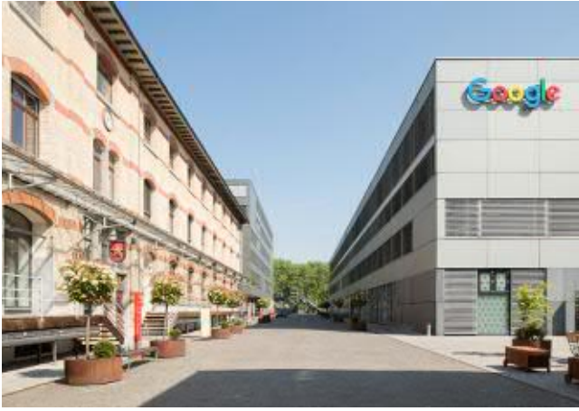
Abb. 7 Gasse zwischen A12, A9 und A14, Richtung Norden
