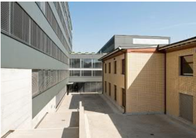
Abb. 10 Durchgang zwischen A9 und A12
