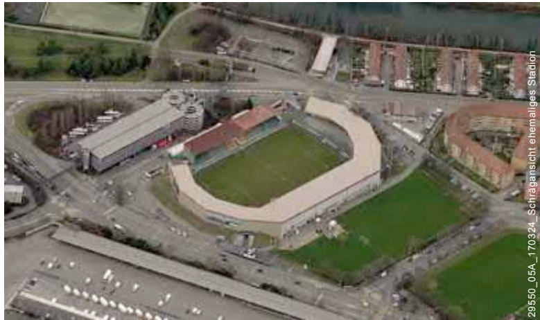
Abb. 2 Zustand vor Einstellung des Fussballbetriebs: Parkhaus Hardturm, Hardturm-Stadion, Trainingsplatz 2
