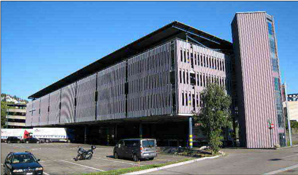
Abbildung 3-3 Parkhaus Hardturm (Quelle: ProjektBeweger, 30.09.2016)
