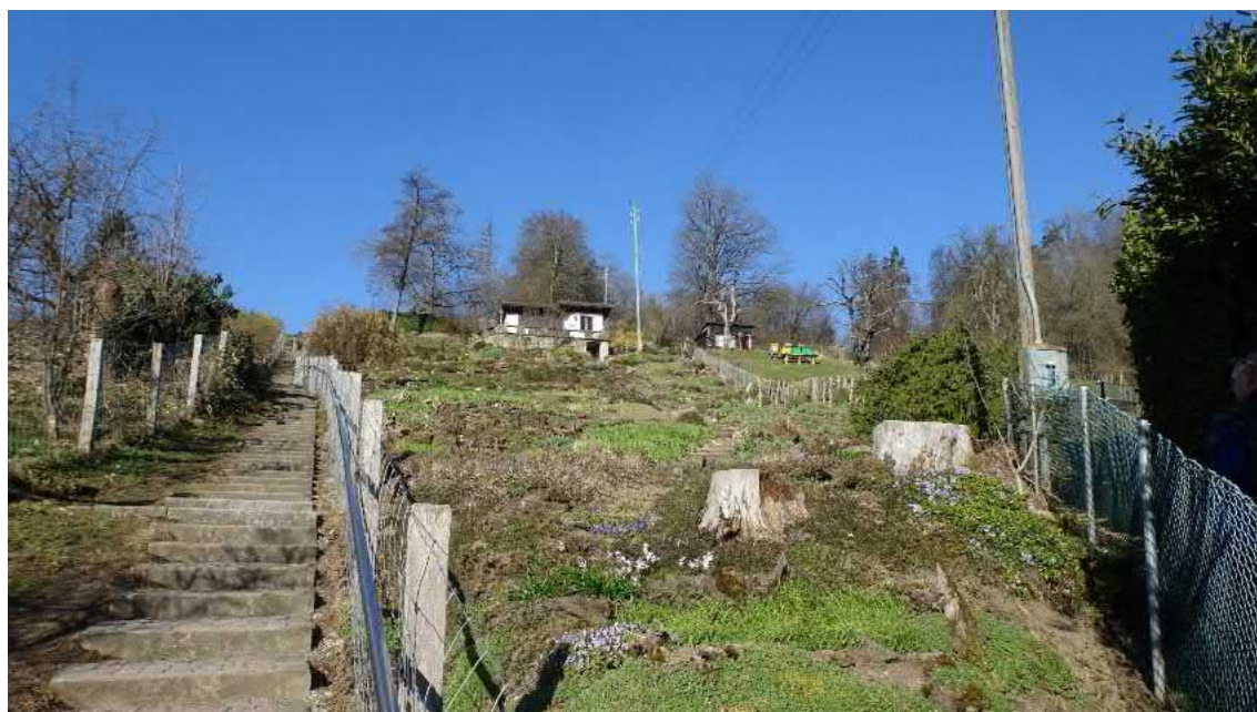
Abb 21. Treppe Im Schaber
