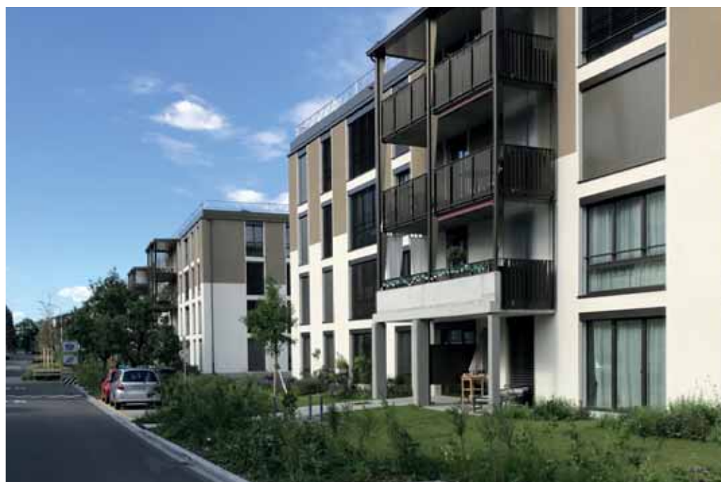
Abb. 36: Referenzbild Vorzone Dreispitz-Strasse mit Längsparkierung
