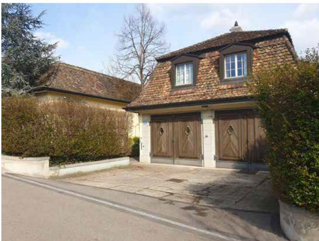
Abb. 5 Remise, aufgenommen von der Ulbergstrasse aus
