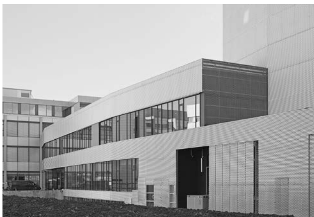
Von Ballmoos Krucker Architekten realisierten beim Informatik-Hauptstandort den Neubau als zentrales Element, das zwei bestehende Baukörper verbindet. (Bild: Georg Aerni)
