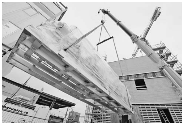
Einbau der Wärmepumpe in der Energiezentrale Aargauerstrasse. (Bild: ewz)
