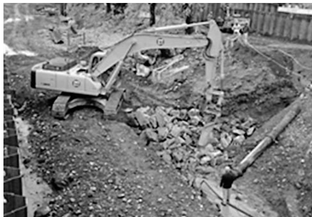
Rohrleitungsbau entlang der Sihl. (Bild: Wasserversorgung)
