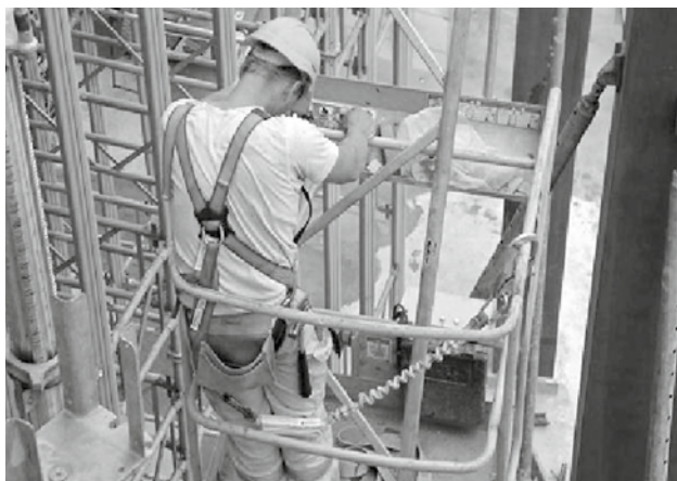
Baukontrolle. (Bild: Marcel Gmür)
