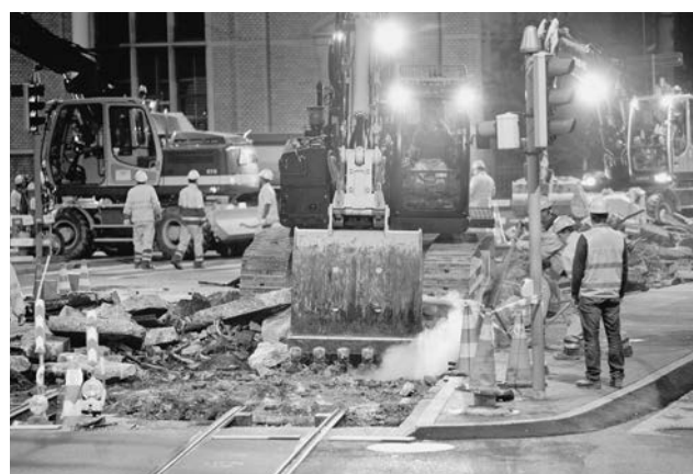
Grossbaustelle am Heimplatz. (Bild: Thomas Burla)
