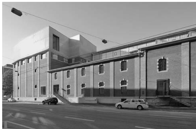
Der fertiggestellte Bau der Löwenbräukunst im westlichen Teil des Löwenbräu-Areals. (Bild: Thies Wachter)
