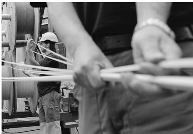
Verlegen von Glasfasern für ewz.zürinet. (Bild: ewz)
