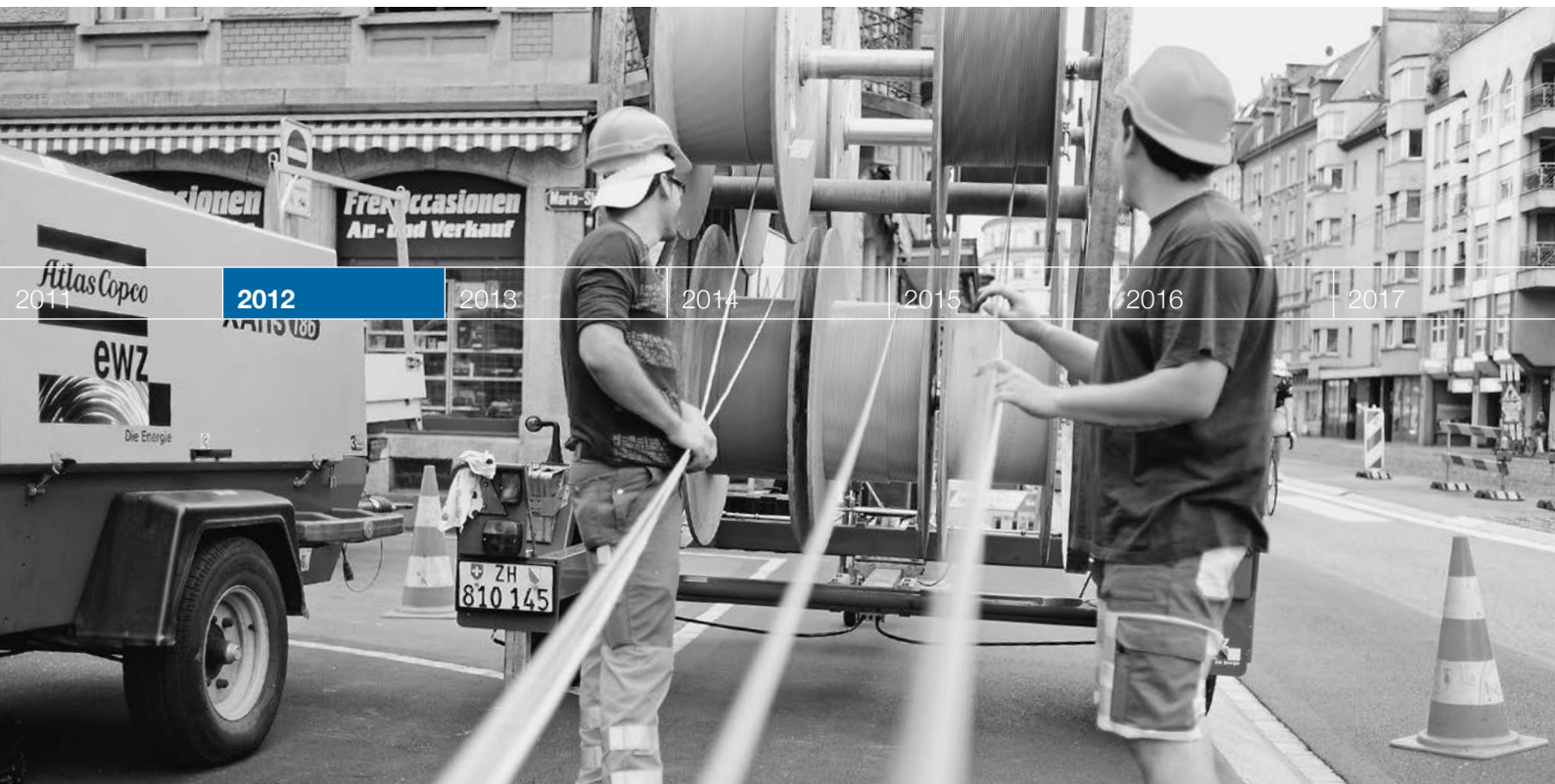
Bild: Bauarbeiten für Glasfasernetz
