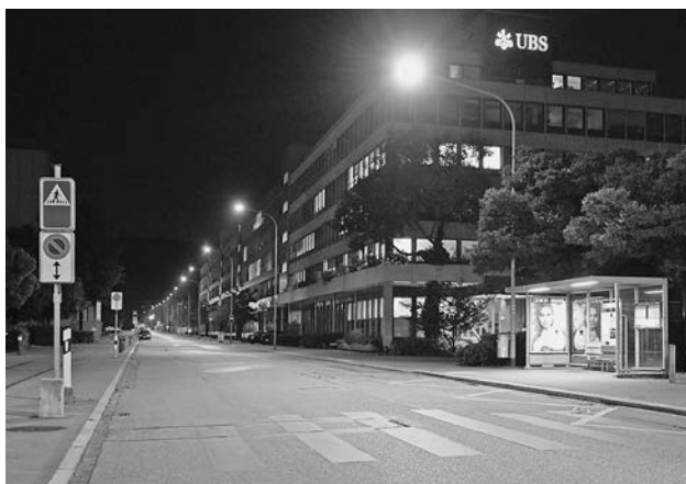
LED-Pilotanlage an der Flurstrasse. (Bild: ewz)
