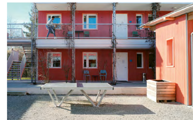
Temporäre Wohnsiedlung und MNA-Aussenstelle Aubruggweg
