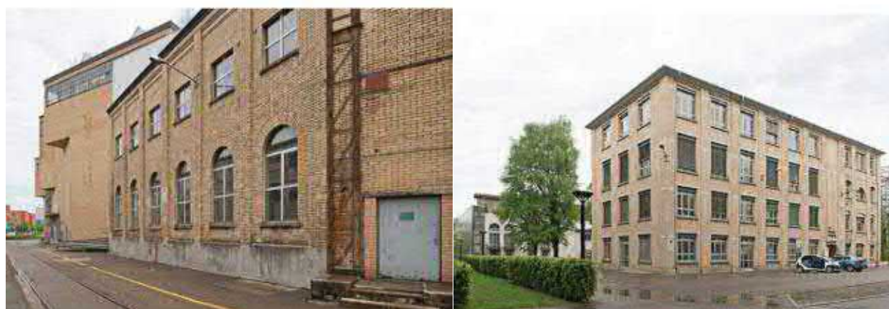
Abb. 8: Versuchslokal II/ Gleichrichterbau und Montagehalle IV an der Birchstrasse und Gebäude 87T am MFO-Park (Bilder: Masterplan, 10.07.2018)
