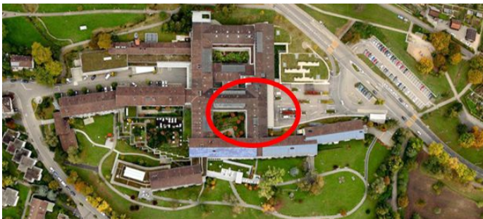
Luftbild Stadtspital Waid mit gekennzeichnetem Perimeter
