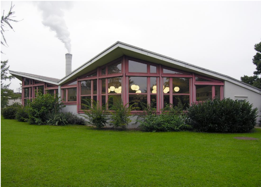
Schulhaus Opfikonstrasse 151/Auzelg von Trudy Frisch von Meyenburg
