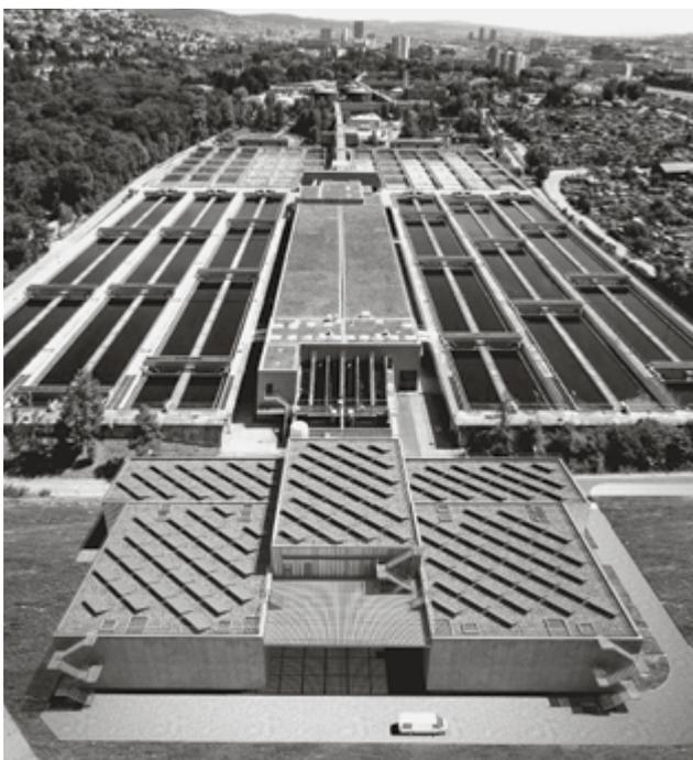
Im Vordergrund die geplante Reinigungsstufe zur Eliminierung von Mikroverunreinigungen. (Visualisierung: ERZ)
