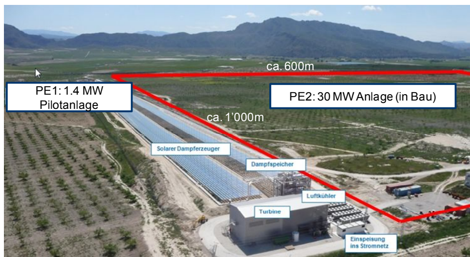
Abbildung 2: Pilotanlage PE1 und Gelände der zukünftigen Anlage PE2 (Quelle: Novatec)
